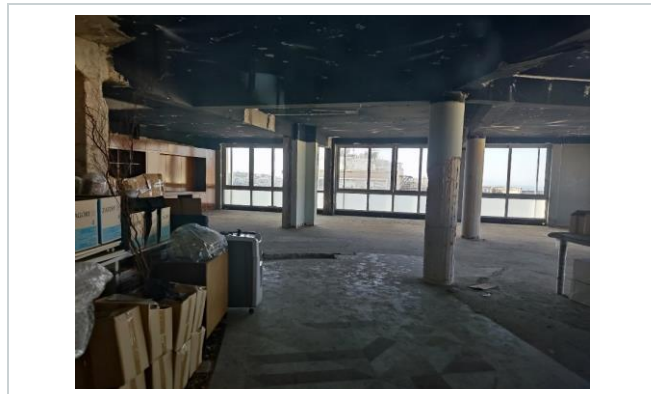
Εσωτερική άποψη ακινήτου 6ος όροφος
